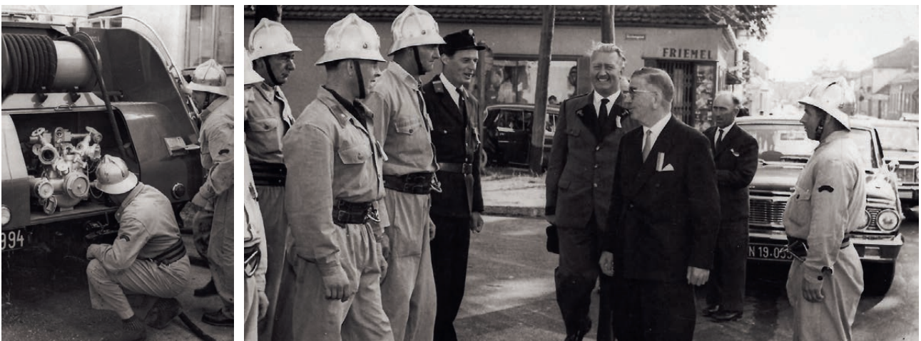
Einbaupumpe des ersten Tanklöschfahrzeuges und Segnung des neuen TLF – Ehrenschutz durch Dr. Figl, 1964
